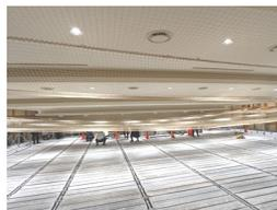
天井耐震化工事はフェールセーフネット工法と呼ばれる対応。大地震など万が一の際に備え、天井部分にケーブルとネットを張
