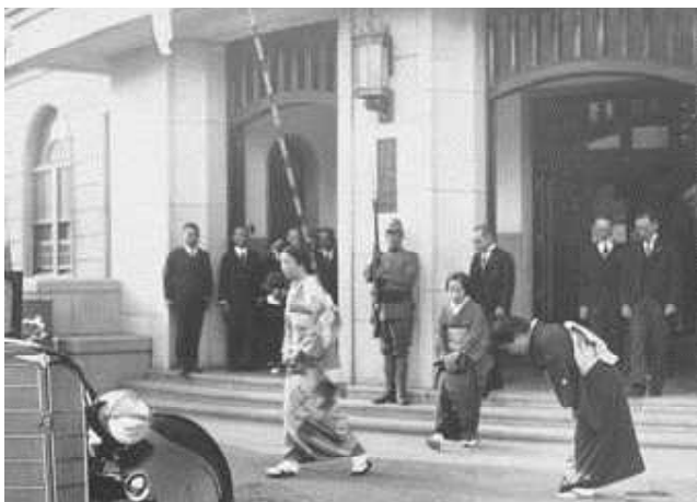
昭和12年10月21日，現在大学の鉄筋コンクリートの校舎落成式に台臨の閑院若宮妃殿下のおかえりのところ
